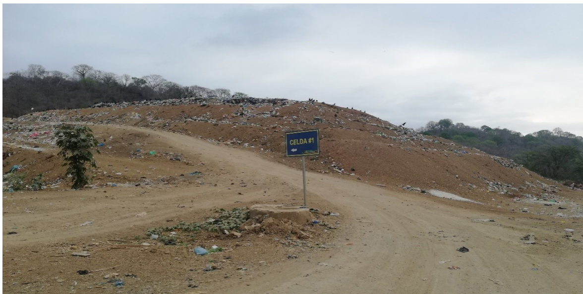
Muestra 5. Celda n°2 del relleno sanitario de la ciudad de Jipijapa.
