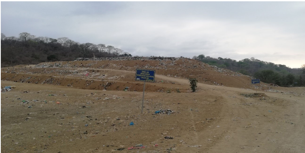
Muestra 4. Celda n°1 del relleno sanitario de la ciudad de Jipijapa.
